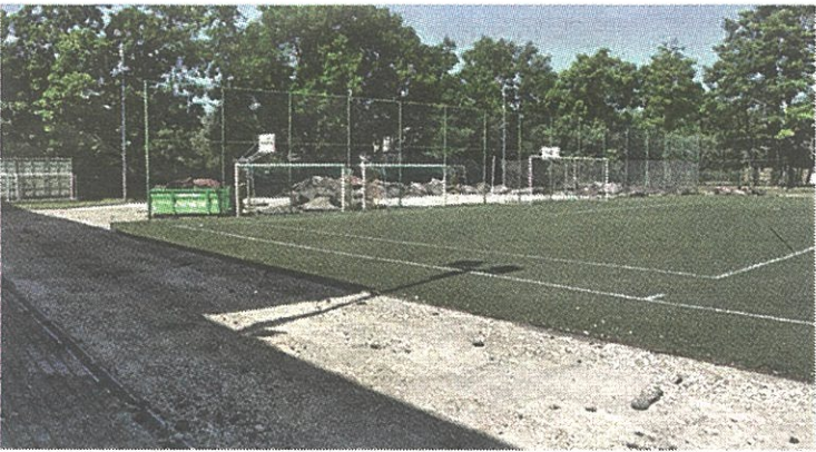
Prace obejmują bazę sportową
